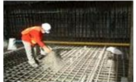
Rắc khô lên bề mặt bê tông lót
