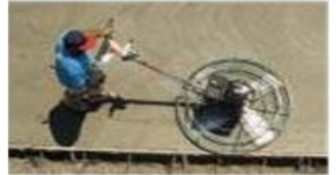
Rắc khô lên bề mặt bê tông nền
